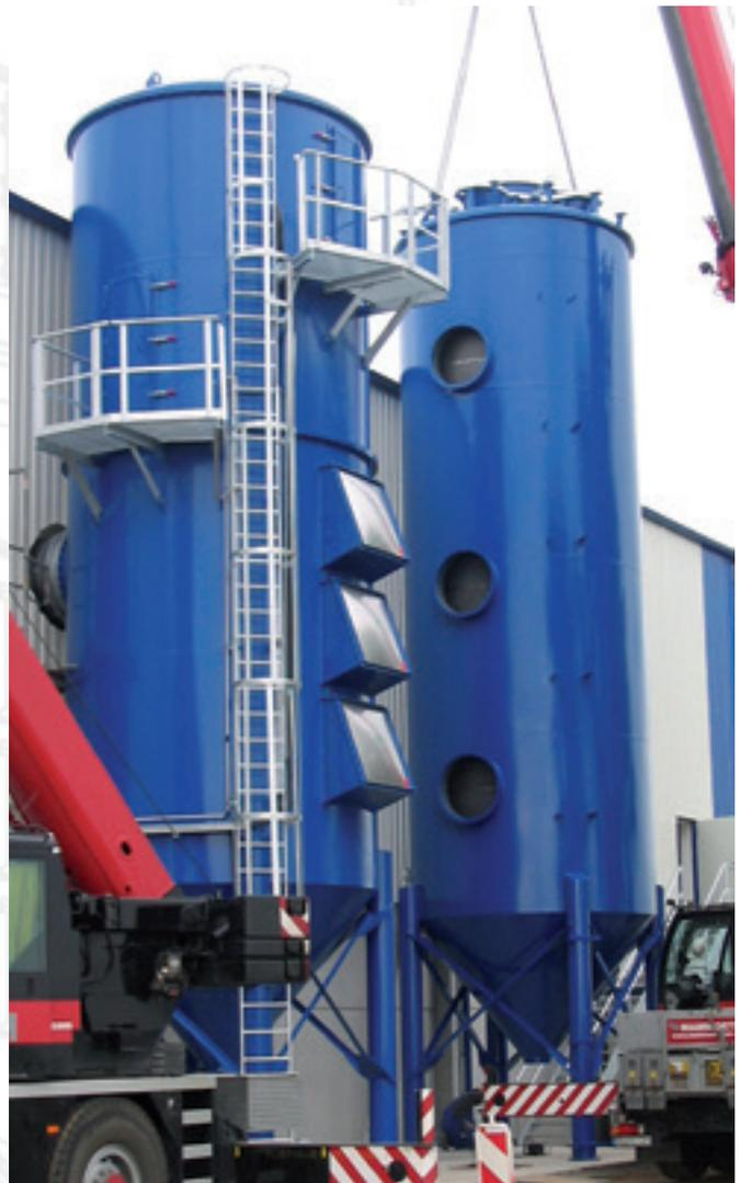
Transport / Aufstellung eines Schlauchfilters und Aktivkohlefilters
